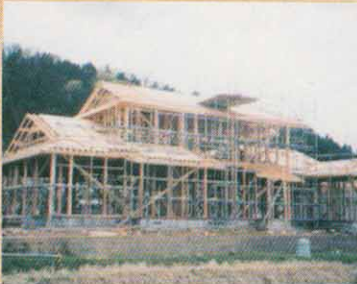
住宅への木材（県産材）利用
