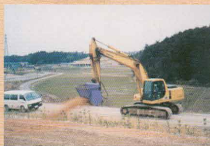
木屑を利用したマルチング材の吹付状況
