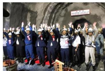
新北陸トンネル貫通
