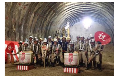
深山トンネル貫通
