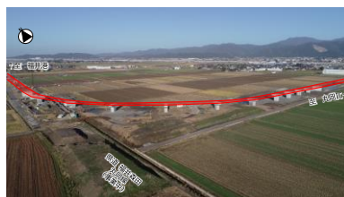
福井港丸岡インター連絡道路
