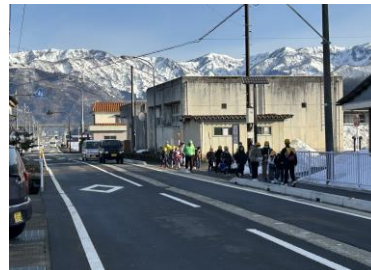
(主)篠尾勝山線 歩道整備
