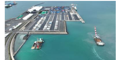
敦賀港 鞠山南地区の施工状況(12月)
