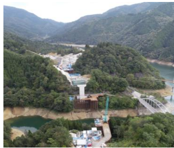
中部縦貫自動車道の施工状況
