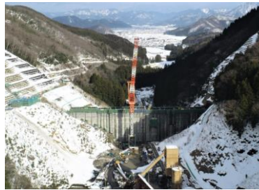
吉野瀬川ダムの施工状況
