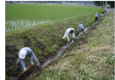
水路の泥上げなど農地の保安全管理
