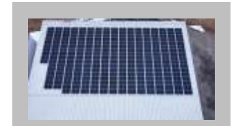
工場屋根への太陽光発電設置
