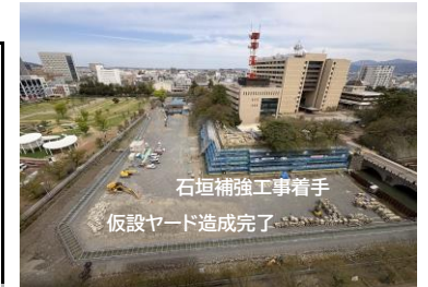
福井城坤櫓等復元工事（お堀の埋立て）
