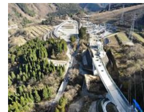
中部縦貫自動車道大野油坂道路
