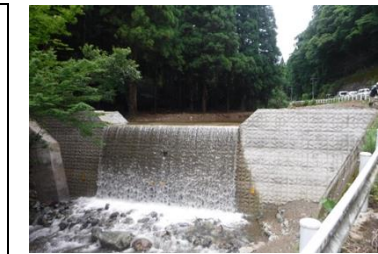
治山ダムの修繕
