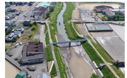
河川拡幅工事（天王川）
