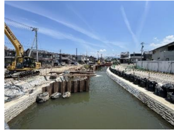
底喰川の改修（拡幅）
