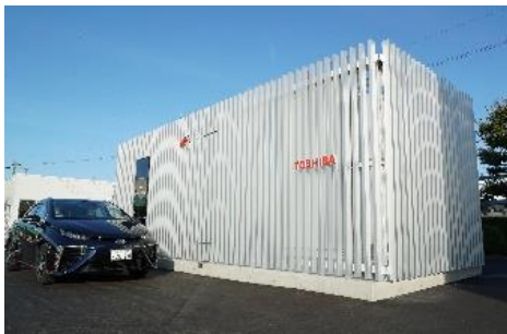
水素ステーション
