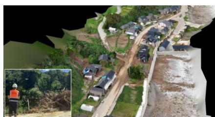
ドローンによる災害調査
