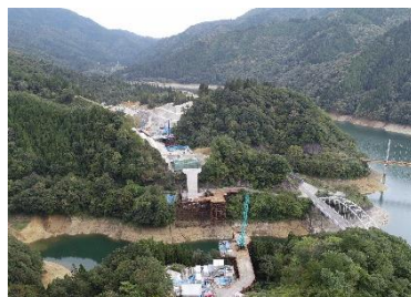
中部縦貫自動車道の整備 （新子馬巢谷橋（仮称））
