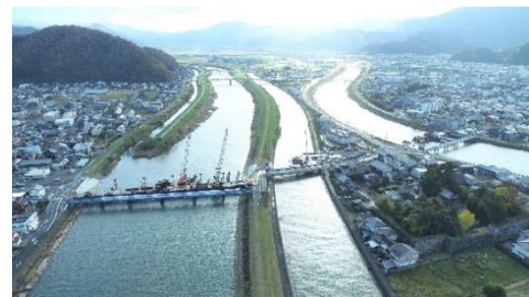
国道162号西津橋、城内橋、大手橋の整備
