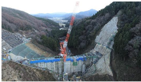
吉野瀬川ダムの整備
