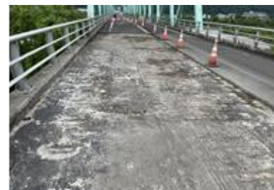
国道416号の橋梁補修（市荒川大橋）
