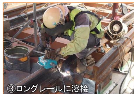
レールの間隔や高さをミリ単位で調節。溶接でつないで最終的な長さ（数km～数十km）のロングレールとなります。
