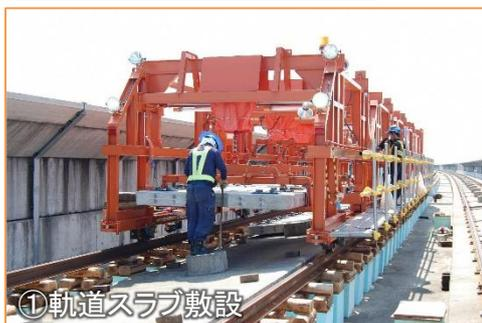
路盤鉄筋コンクリート上に溶接した長さ200mの長尺レールを敷設（工事用仮軌道）し、専用車両で軌道スラブを敷設します。
