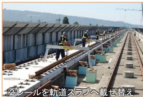
軌道スラブ敷設後、工事用仮軌道に使用していた長尺レールを軌道スラブ上に載せ替えて溶接し、約1km程度の長さにします。
