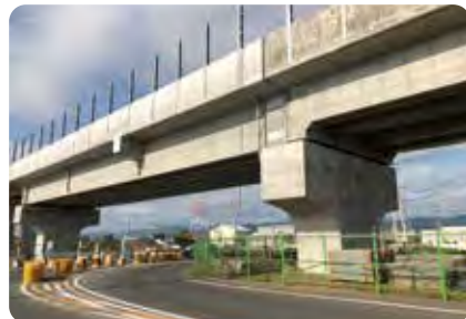
工事のようす 森田高架橋(福井市)
