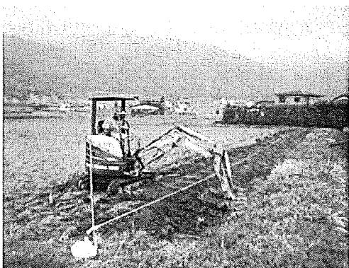
写真 3.2-3 退避路の設置（施工中）
