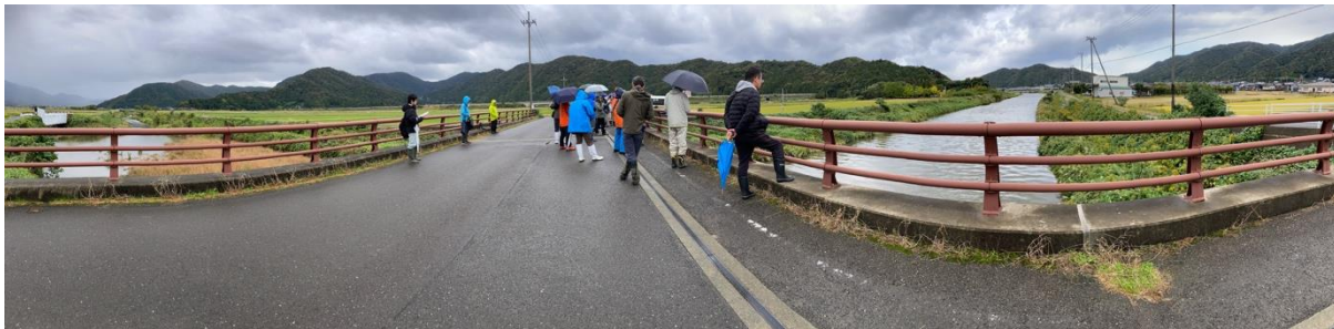
上古橋の下流側（写真左側が上流側、右側が下流側）
