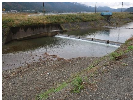
はす川に設置されている取水堰
