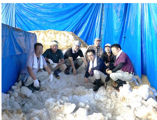
雪室の解体作業(右から2人目)
