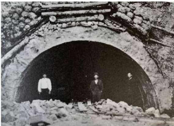
図1. 1930年代初期に行われた三方五湖流域の河川改修、写真は崩落した嵯峨隧道（日向湖と水月湖を結ぶ暗渠）の再掘削時のもの。
