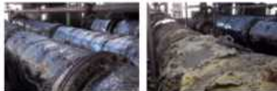
正常状態、ただしフランジ部分は未対策 保温材の損傷箇所は補修が必要
