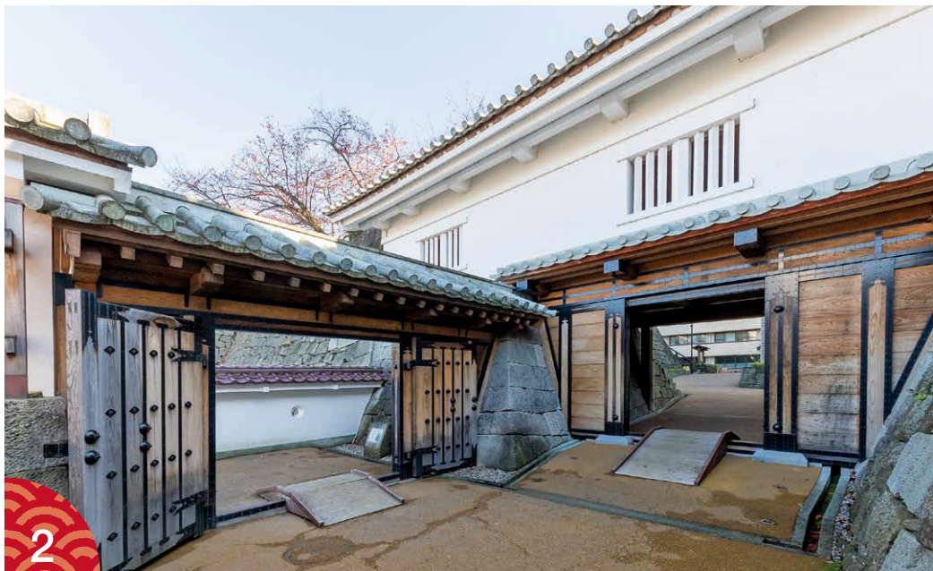
棟門(左)、櫓門(右)と枅形の石垣で形成されている山里口御門
