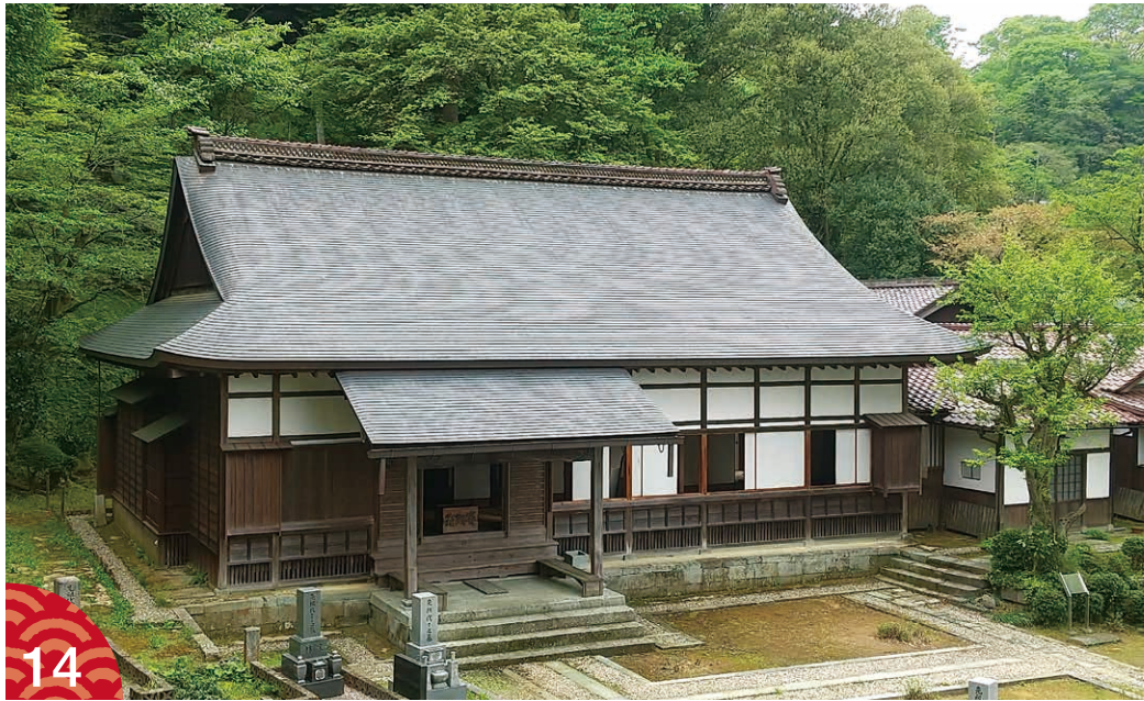
福井城本丸御殿の建物を移築した瑞源寺の本堂
