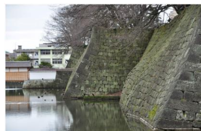
本丸西側の石垣の状況
