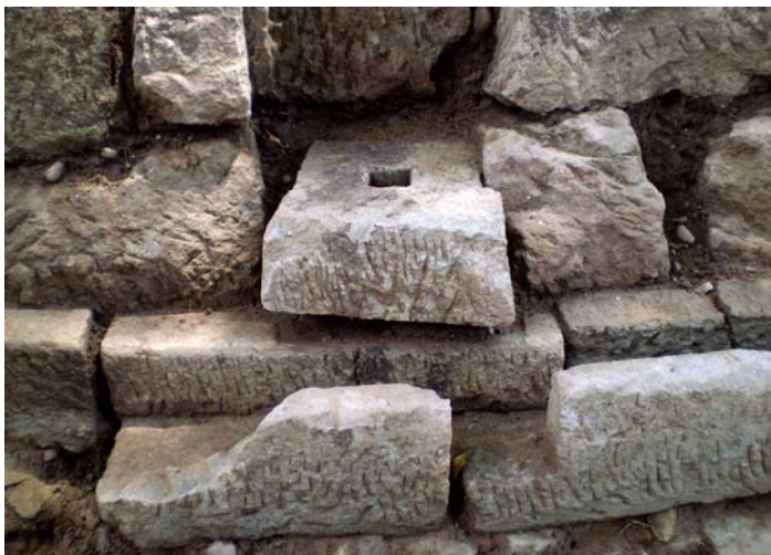
写真3 礎石と暗渠1（北より）
