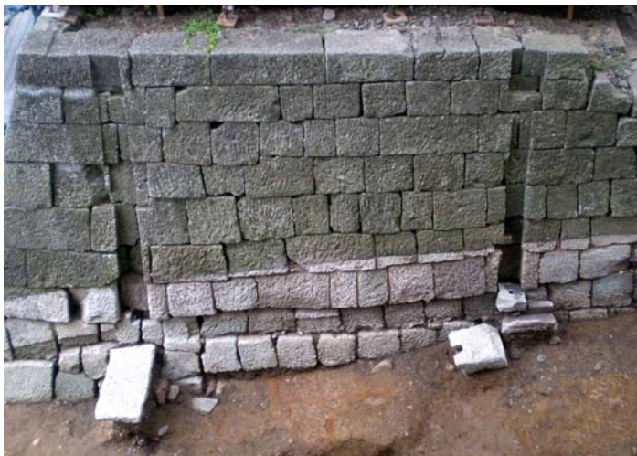
写真2 柱受け1・3（南より）
