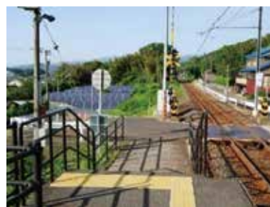
広場機能がまったくない駅の例 (西敦賀駅)
