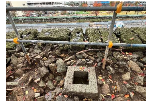
土堀部の状況（令和7年11月）
