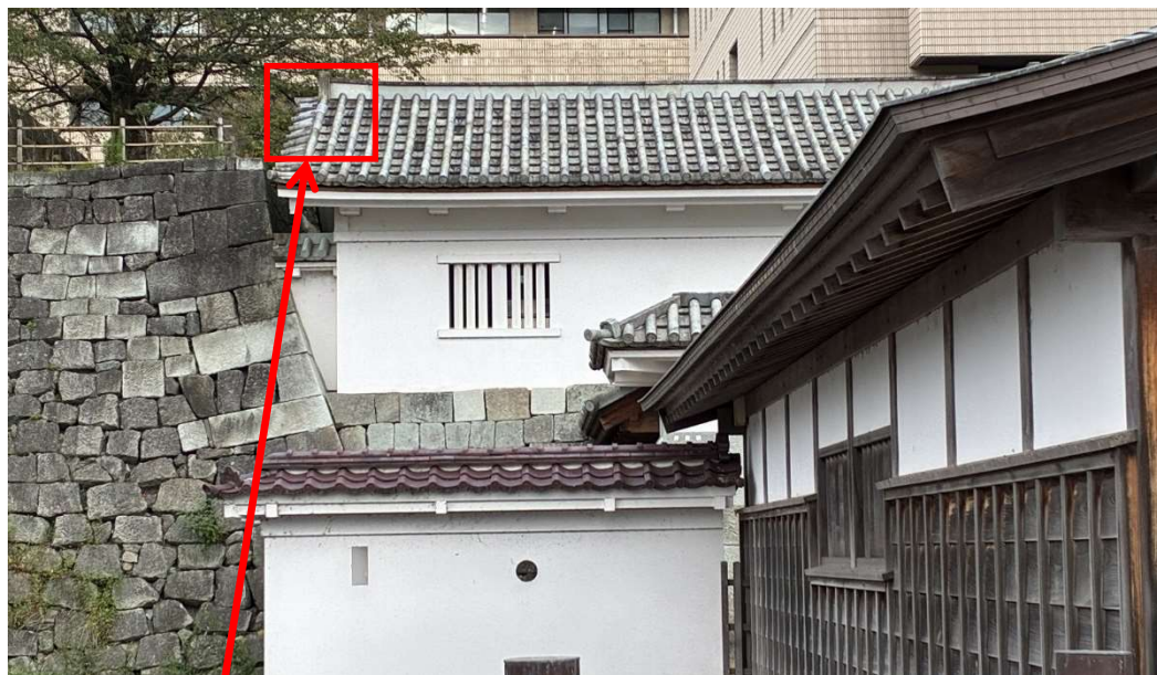
瓦の見え方（御廊下橋 地上より）
