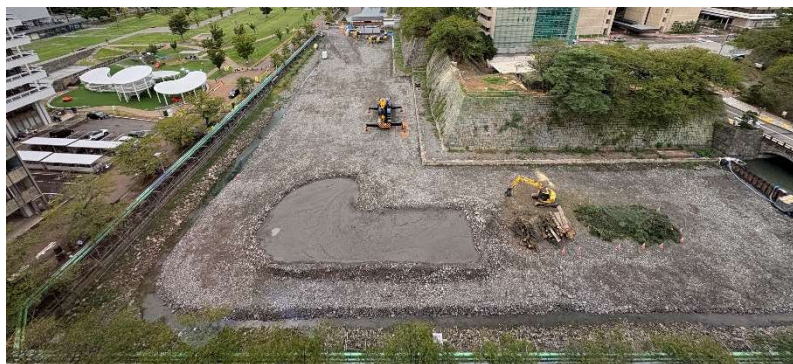
仮設ヤードの状況（令和7年9月末現在）
