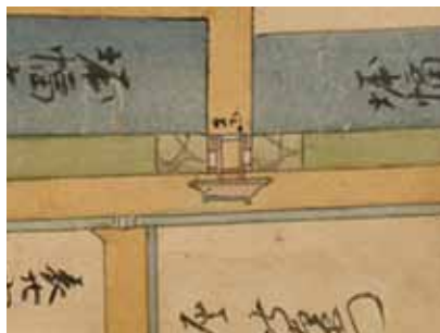
D16 御泉水裏_舎人御門
