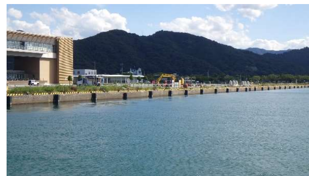
小浜漁港岸壁
