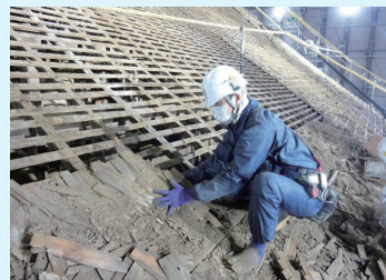
土居葺きの解体
