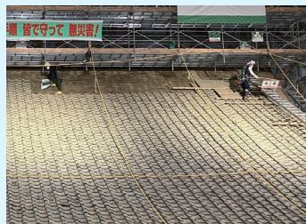
屋根瓦を降ろす
