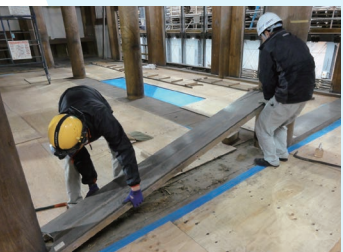
無目敷居（建具の溝の無い敷居）の解体
