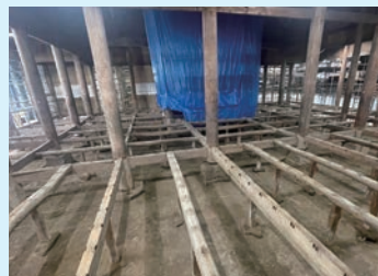
柱と骨組みだけになった床
