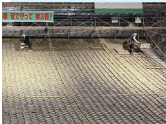
屋根瓦を降ろす
