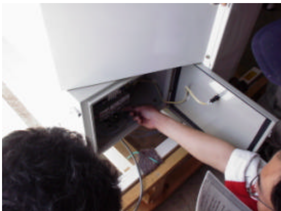
制御スイッチの蓋：ここに「自動」「手動」等のスイッチがある。変更は慎重に。
