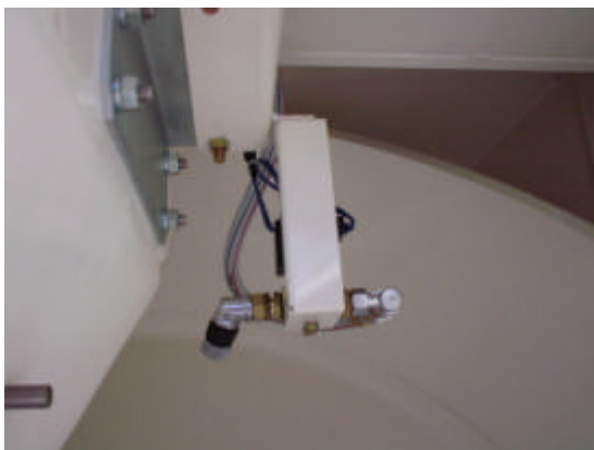
ノズル調整：水が出るノズル。ノズルの先に洗面器をあてて作業前に調整する。ドラムが濡れたらよく拭いておく。
