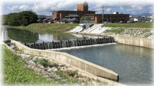
用水の取水のため堰体を起立させて堰上げる
