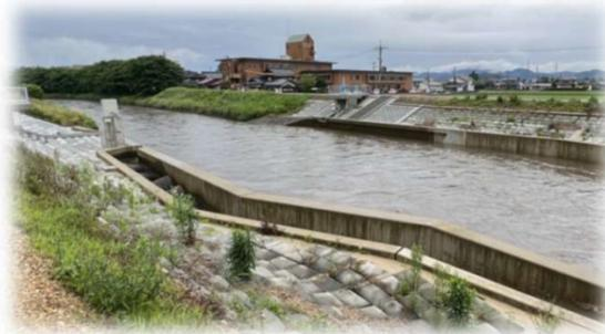
増水時は堰体を倒伏させて流水を流下させる
