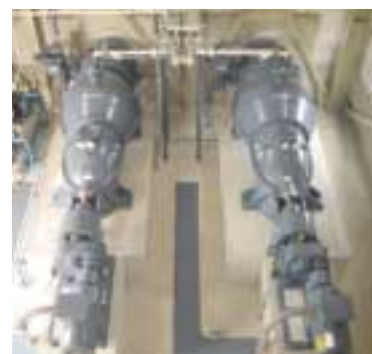
排水機施設 ( 1000m/m × 2台 )
