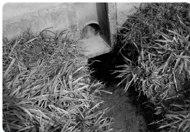
通常の排水口の下を掘って、水田に掘った排水溝を基幹排水につないだ例
