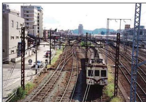
駅全景 (北方向より撮影 平成2年)
