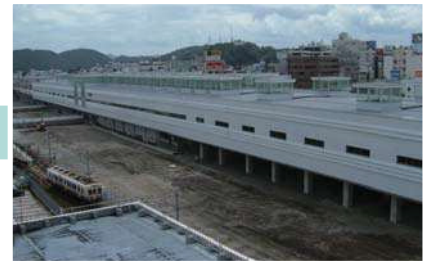
高架切替後、旧駅撤去 (平成17年7月)
