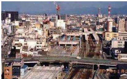
駅部高架橋構築 (平成14年11月)
