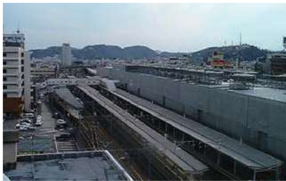
駅部上屋建方 (平成16年4月)
