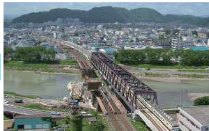
旧架橋撤去 (平成17年5月)
