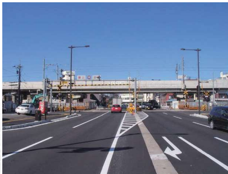
中央線（東方向より撮影）
