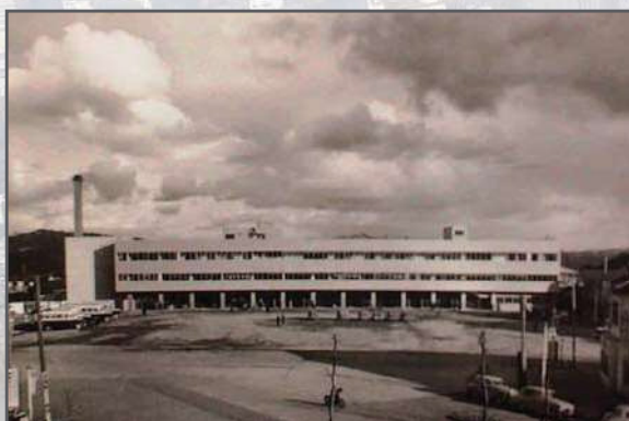
全国6番目の民衆駅として完成した駅 （昭和27年4月）
