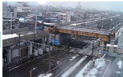
日之出跨線橋撤去 (平成16年2月)
