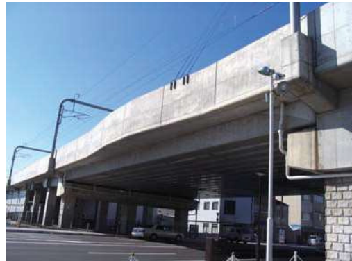
架道橋桁側面
