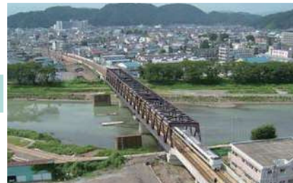
旧架橋撤去 (平成17年8月)
