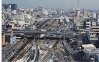
仮線敷設 (平成12年3月)
