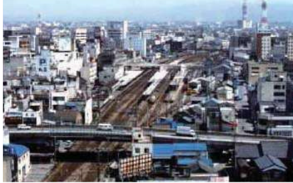
着工前 (平成10年4月)
