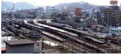
着工前 (平成10年4月)
