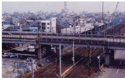
高架橋構築・日之出跨線橋着工前 (平成13年3月)
