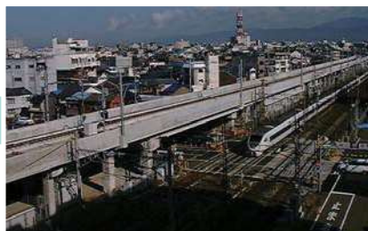
日之出架道橋完了・仮踏切4車線に (平成16年11月)
