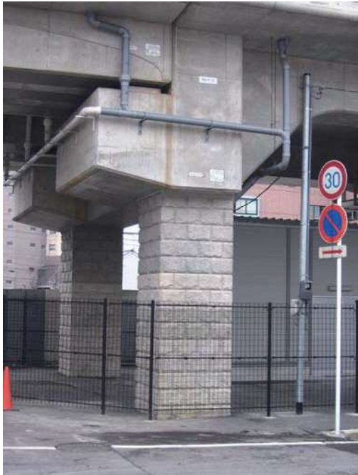
架道橋下部工
