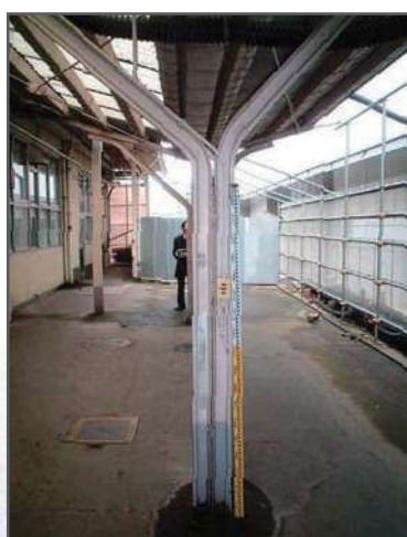
1888年ごろ製造された古いレールは 照明支柱に再利用予定
