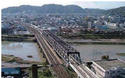
軌道敷設 (平成16年11月)
