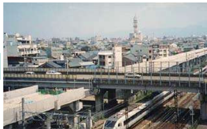
高架橋構築・日之出跨線橋2車線化 (平成15年8月)
