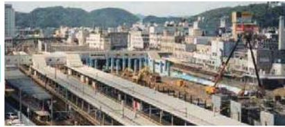
駅部高架橋構築（柱） (平成14年9月)
