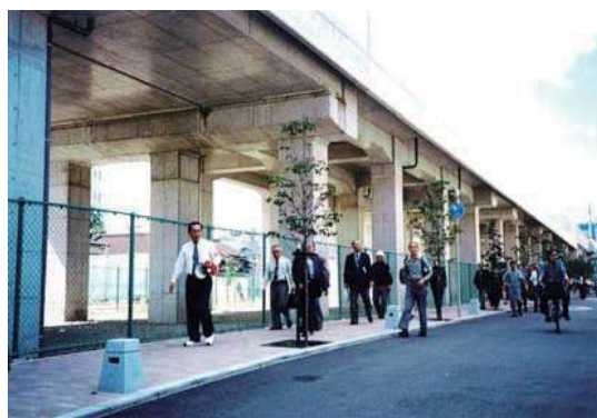
現地視察(平成7年度川西市)
