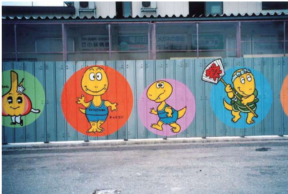
工事用フェンス
