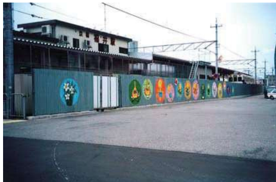
工事用フェンス
