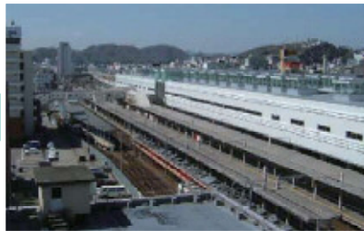
高架切替前 (平成17年4月)
