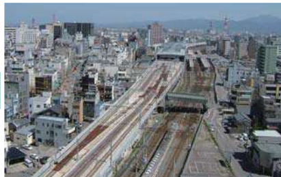
豊島跨線橋撤去、高架切替前 (平成17年4月)
