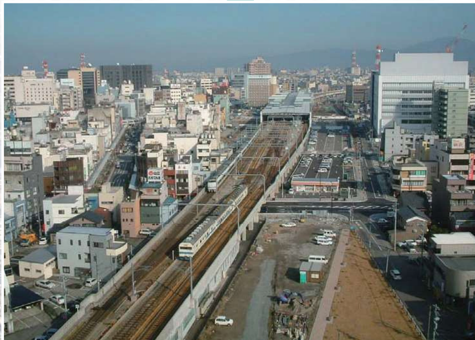
完成 (平成18年2月)
