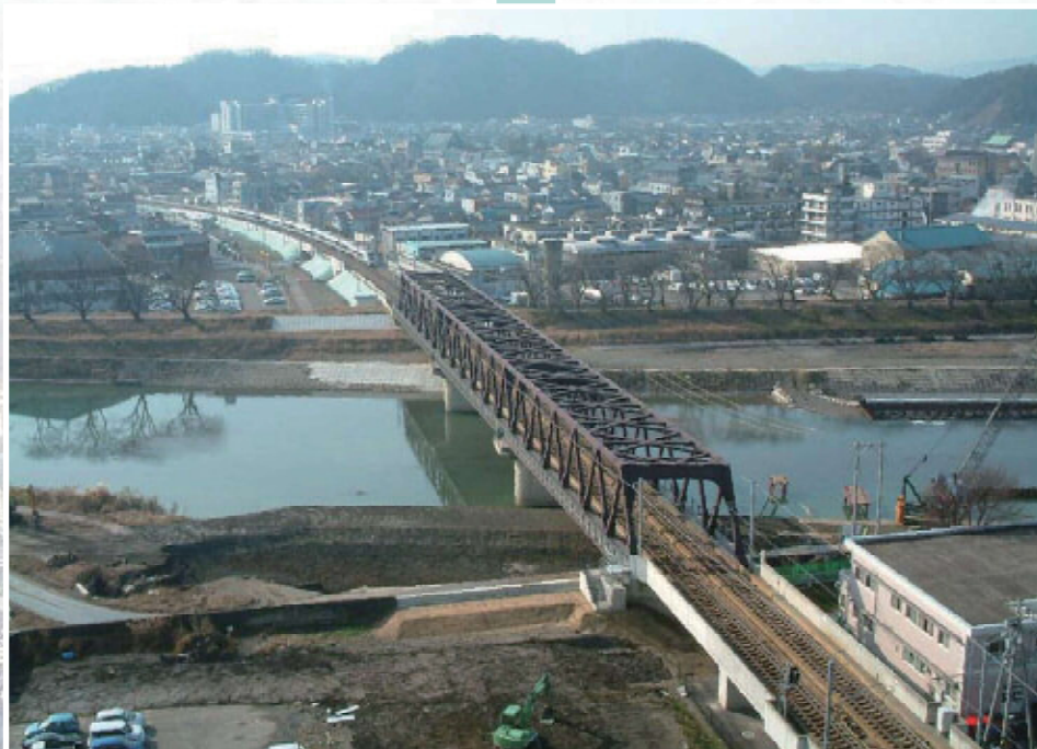
完成 (平成18年2月)
