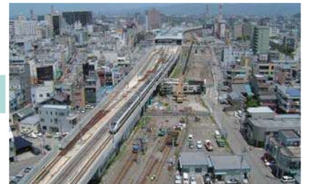
高架切替後、豊島跨線橋撤去 (平成17年5月)
