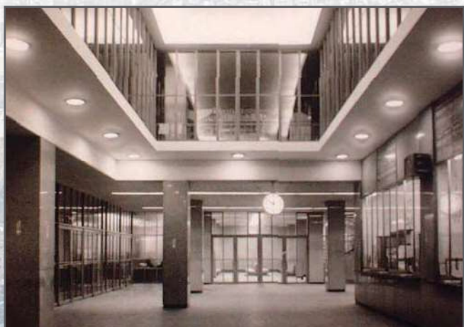
駅舎内部（2階まで吹き抜けのモダンな構造） （昭和27年4月）
