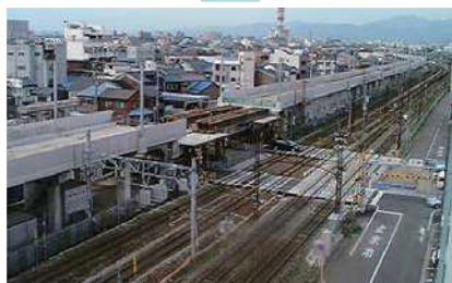
日之出架道橋構築 (平成16年4月)
