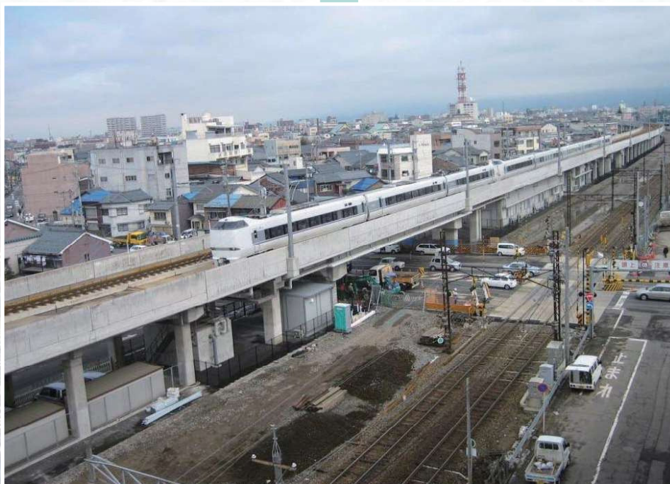
完成 (平成18年2月)
