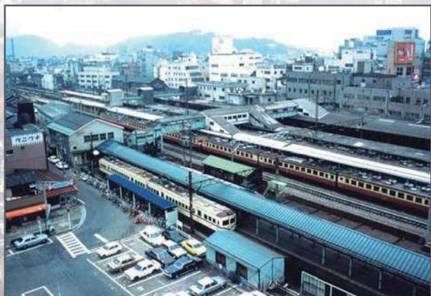
東側からの駅構内 (平成2年)
