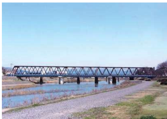
足羽川橋梁(下流より撮影)
