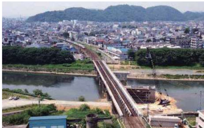
下部工構築 (平成12年5月)
