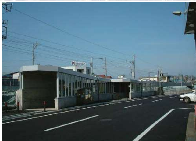
木田地下道（東方向より撮影）
