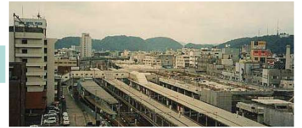
駅部高架橋構築（床版） (平成15年6月)
