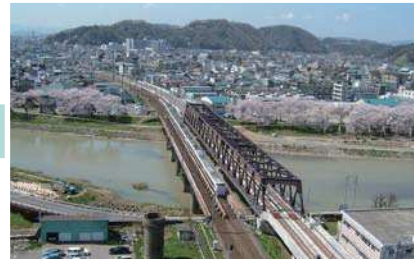
軌道敷設 (平成16年4月)
