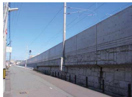
擁壁部化粧型枠
