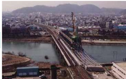
上部工架設 (平成13年3月)
