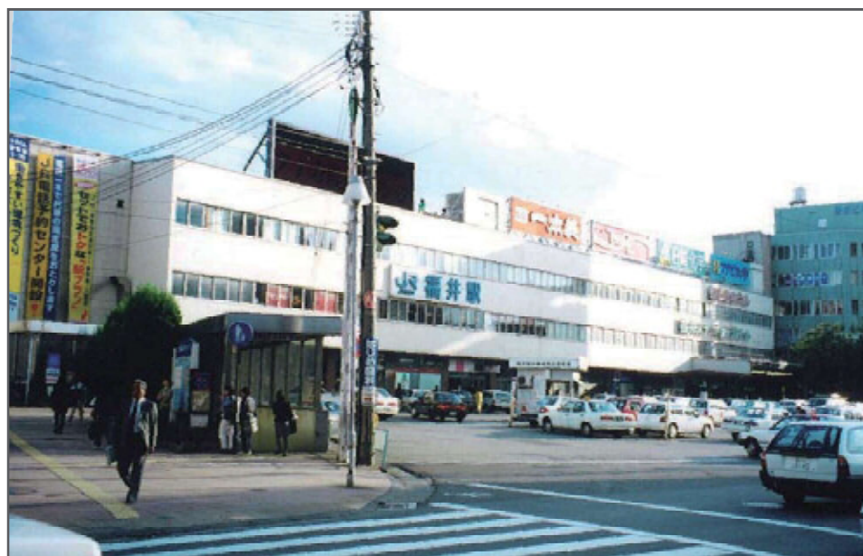
高架切替前の駅
