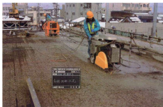
床版カッター切断
