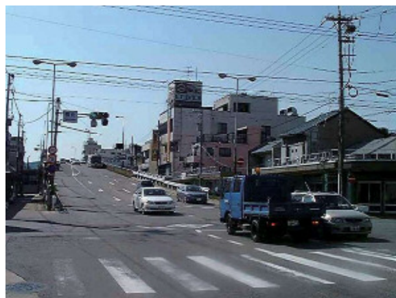
着工前(東方向より撮影)
