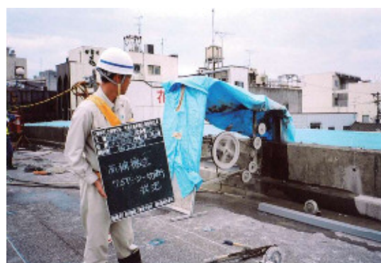
高欄ワイヤーソー切断
