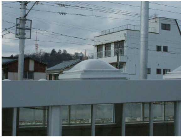
木田地下道(トップライト外側)
