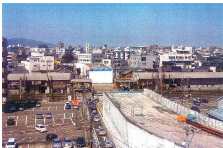
JR北陸線部撤去完了
