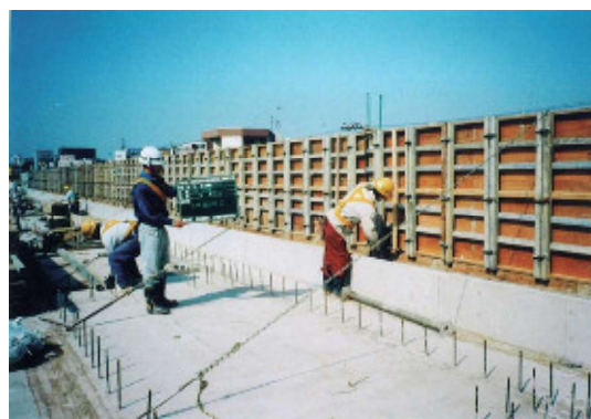
高欄型枠組立工
