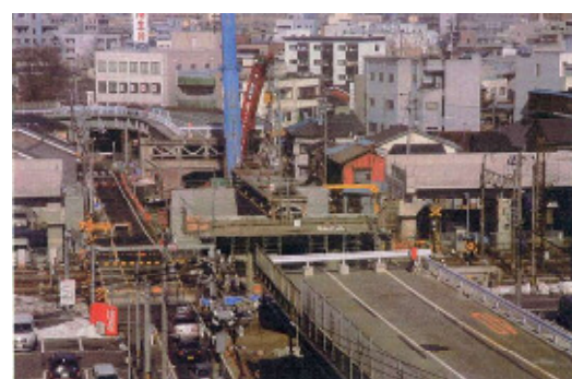
550tクレーン撤去④
