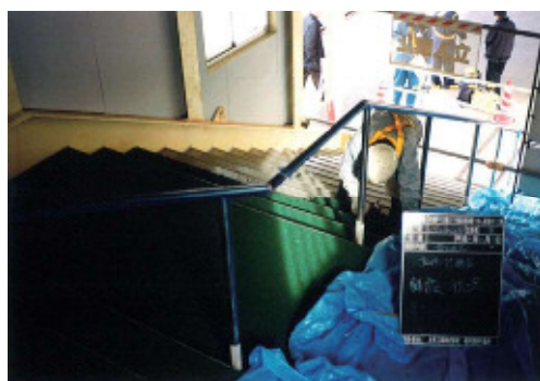
下りホーム階段工
