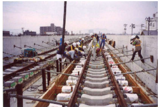
弾性直結軌道コンクリート工
