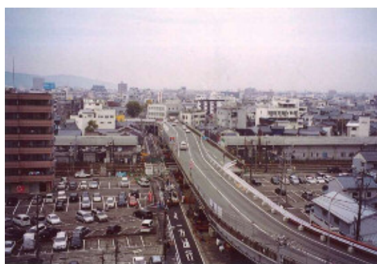
跨線橋2車線化
