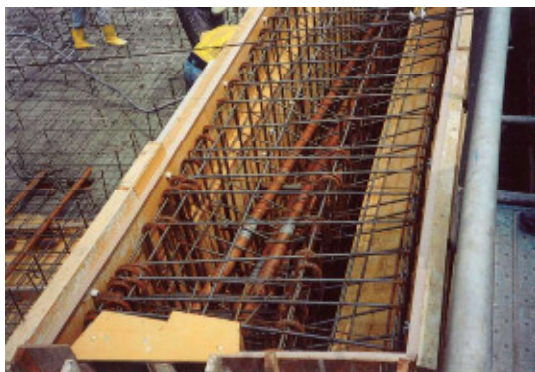
桁鉄筋・型枠工
