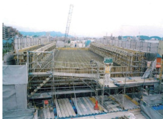
床版鉄筋・型枠工
