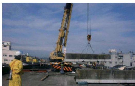
160tクレーン撤去
