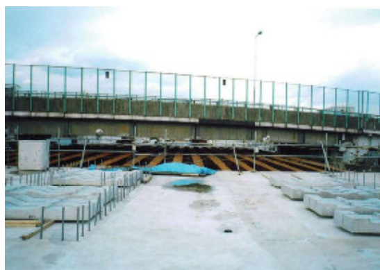
H鋼桁架設工
