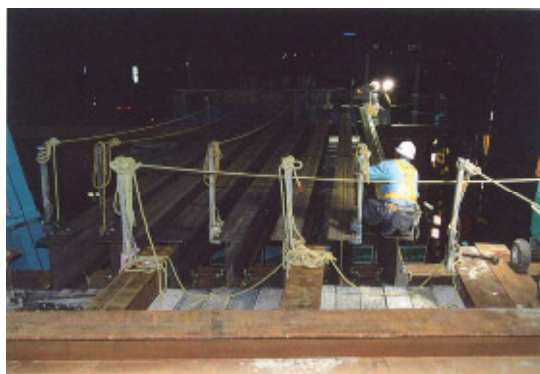
支保工設置工
