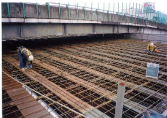
上面鉄筋工
