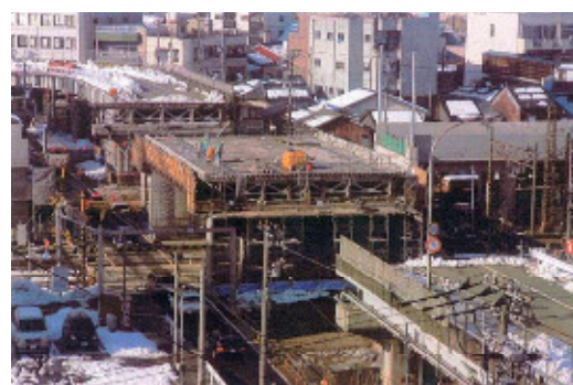
550tクレーン撤去①
