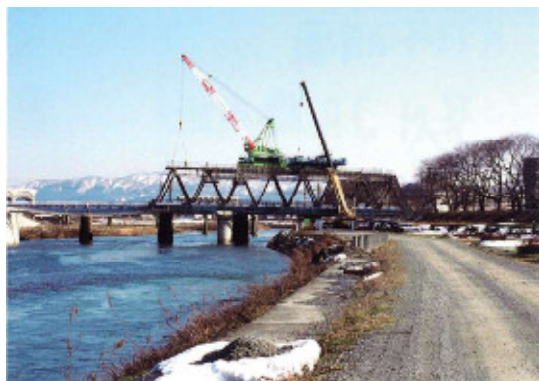
架設工(トラベラークレーン工法)
