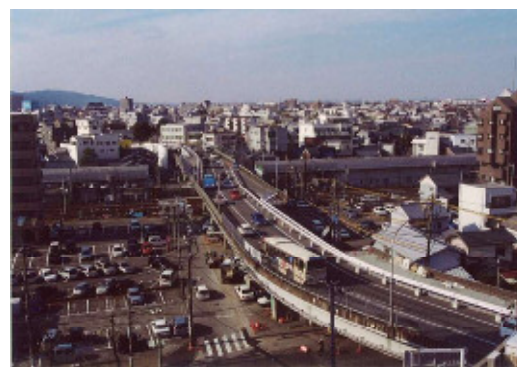
跨線橋 2車線化
