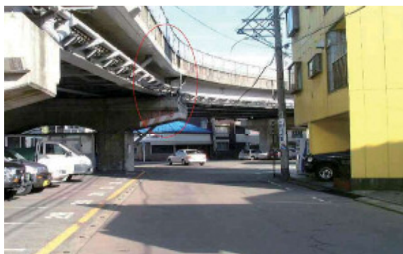
先行撤去した橋脚・桁の一部
