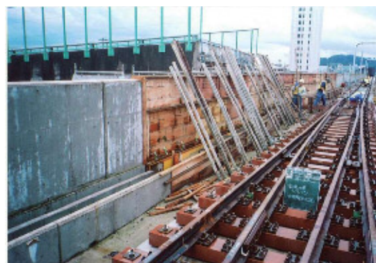
高欄型枠工
