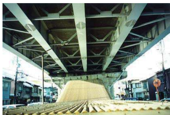
着工前(跨線橋下面)
