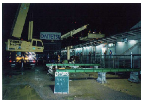
新旅客通路桁架設
