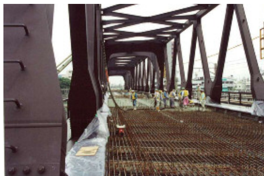
床版コンクリート工
