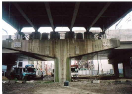
高架橋部撤去完了
