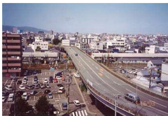
着工前(東方向より撮影)
