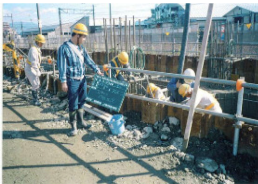
地中梁コンクリート打設工
