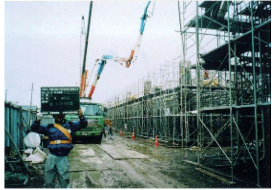
柱コンクリート打設工
