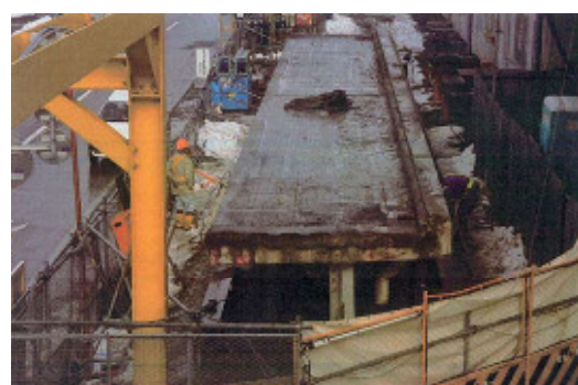
550tクレーン撤去②
