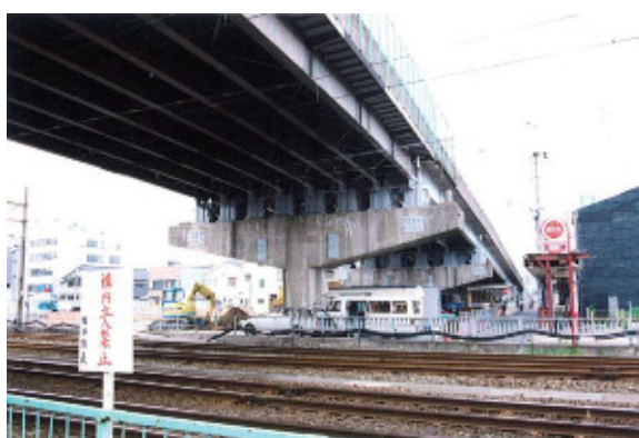
ジャッキアップ完了
