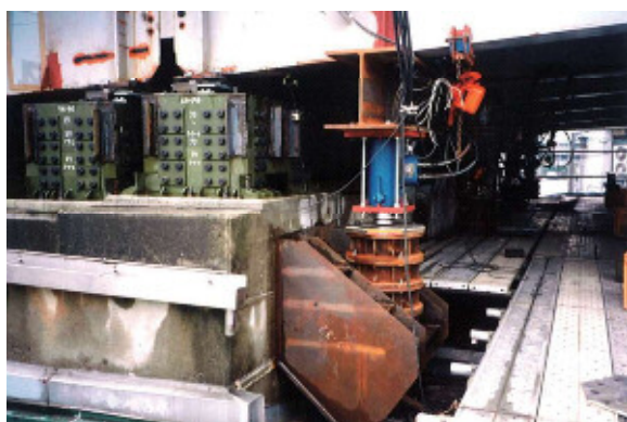
ジャッキアップ状況
