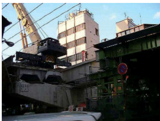
160tクレーン撤去(桁)
