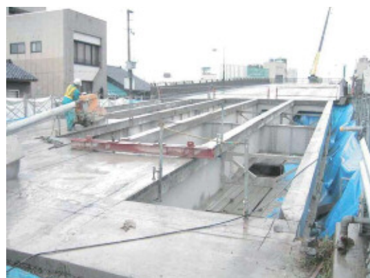
160tクレーン撤去(桁)
