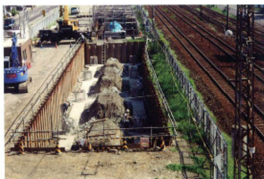
基礎杭ハツリ工
