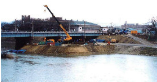
仮設施工ヤード工
