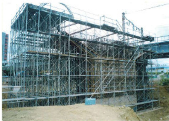
躯体コンクリート型枠支保工
