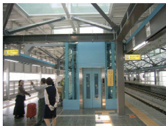
エレベーター
