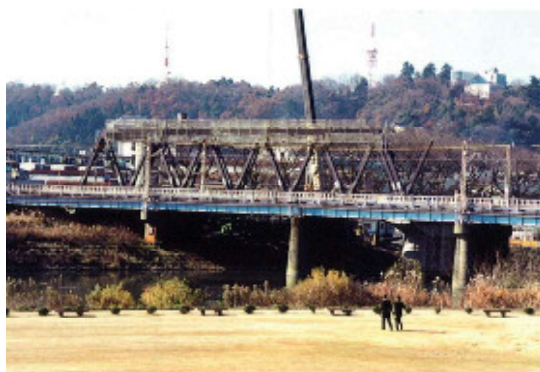
架設工(ベント工法)
