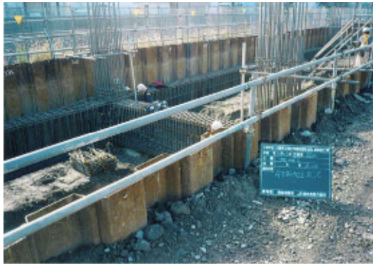
地中梁鉄筋組立工
