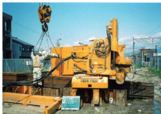
サイレントパイラー圧入工
