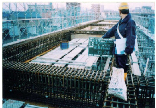
梁鉄筋組立工
