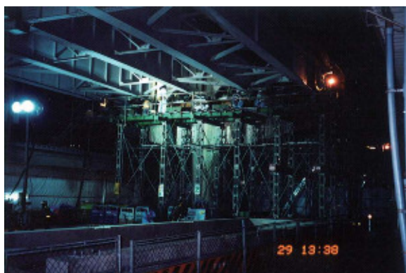
ジャッキアップ状況
