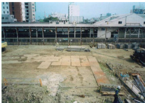
新旅客通路ヤード
