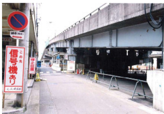
ジャッキアップ完了
