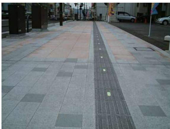
城の橋線(歩道御影石)
