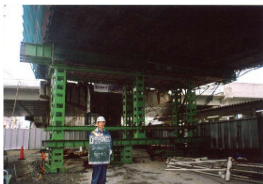
補強用ベント設置
