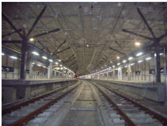
弾性直結軌道コンクリート工
