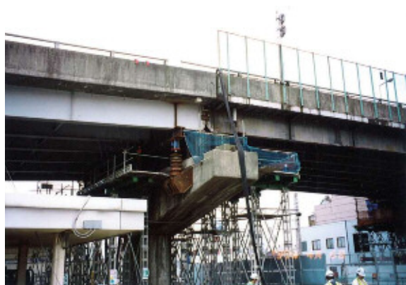
ジャッキアップ状況
