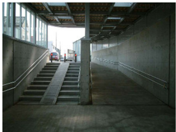
木田地下道(階段・斜路)
