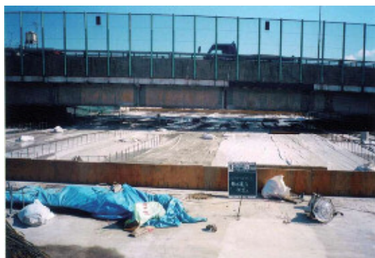
床版コンクリート養生工
