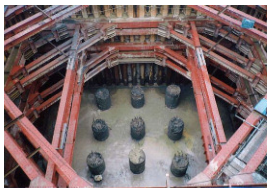
均しコンクリート工
