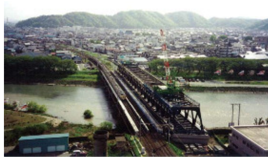
架設工(トラベラークレーン工法)
