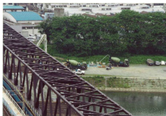
床版コンクリート工
