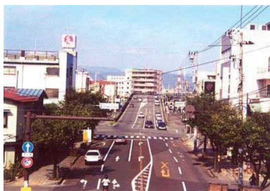
着工前(東方向より撮影)
