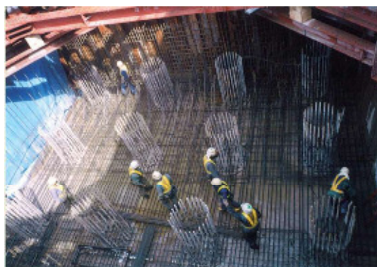
基礎鉄筋組立工
