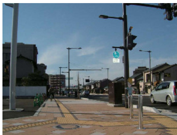
中央線(照明、電線共同溝)
