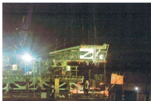
550tクレーン撤去⑤
