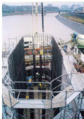
基礎コンクリート打設工
