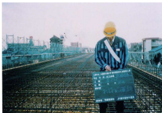
床版鉄筋組立工
