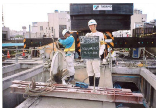
床版カッター切断
