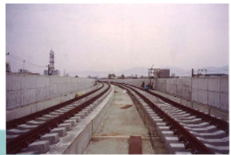
弾性直結軌道コンクリート工
