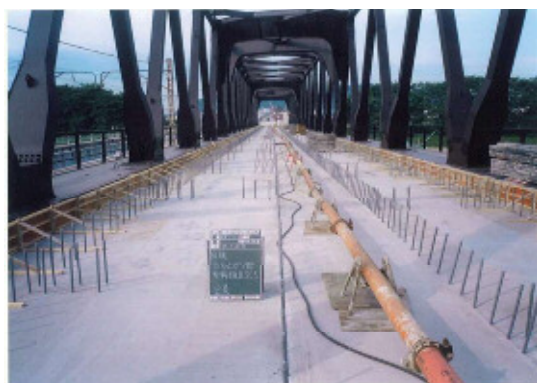
床版地覆型枠工
