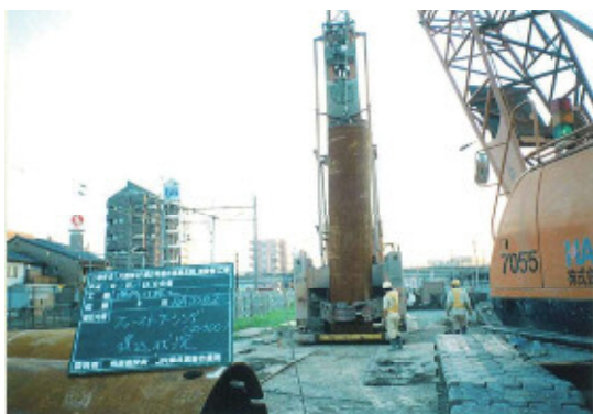
基礎杭掘削工
