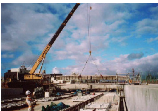
160tクレーン撤去(桁)
