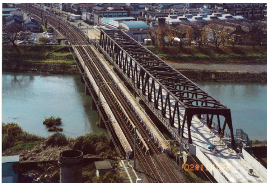
床版完成全景
