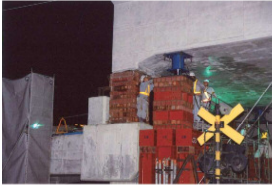
架設工(ジャッキダウン)
