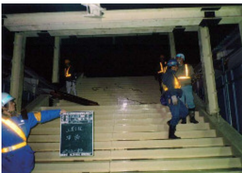
下りホーム階段工
