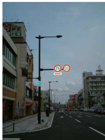
城の橋線(照明、電線共同溝)
