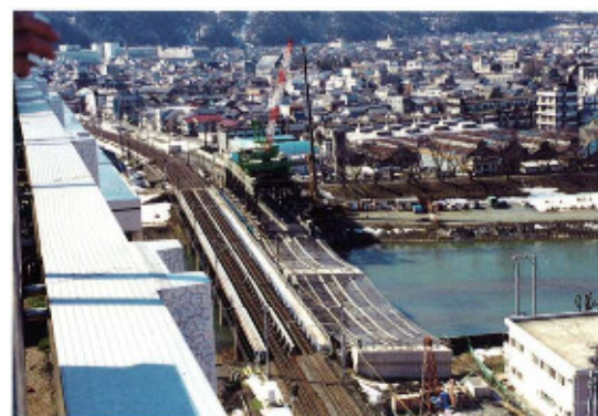
架設工(足場工)
