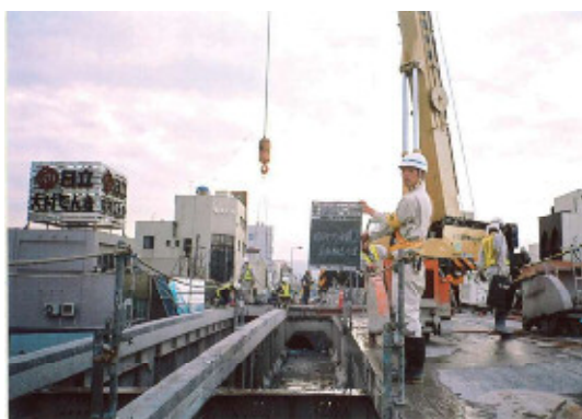
160tクレーン撤去(桁)
