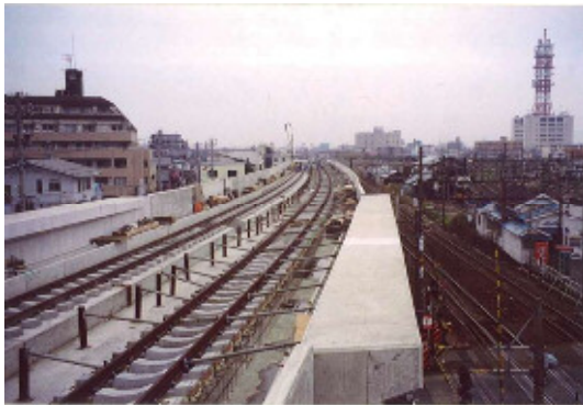
弾性直結軌道コンクリート工
