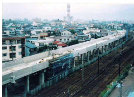
高欄型枠全景
