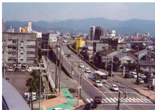
着工前(西方向より撮影)
