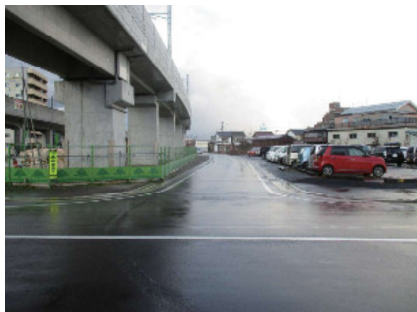
高架側道3号線（起点側）
