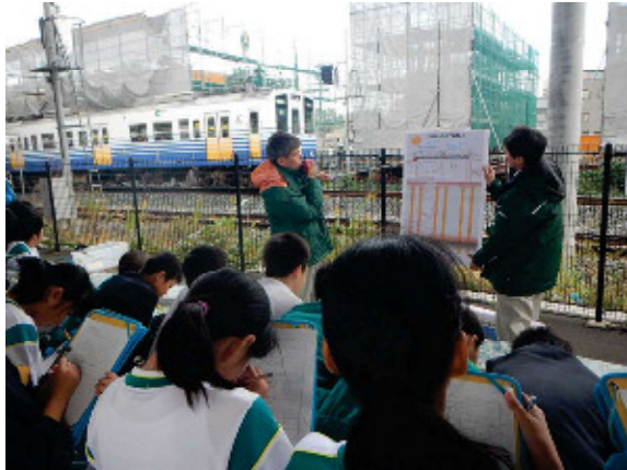
写真3 工事説明の様子
