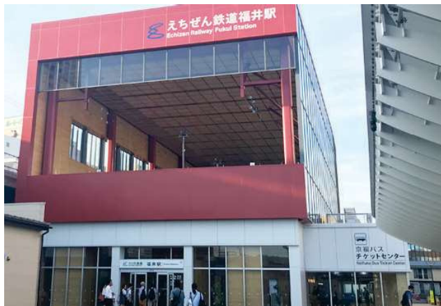
写真3 えちぜん鉄道福井駅舎の南側
