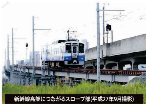
写真2 新幹線高架から地上につながるスロープ
