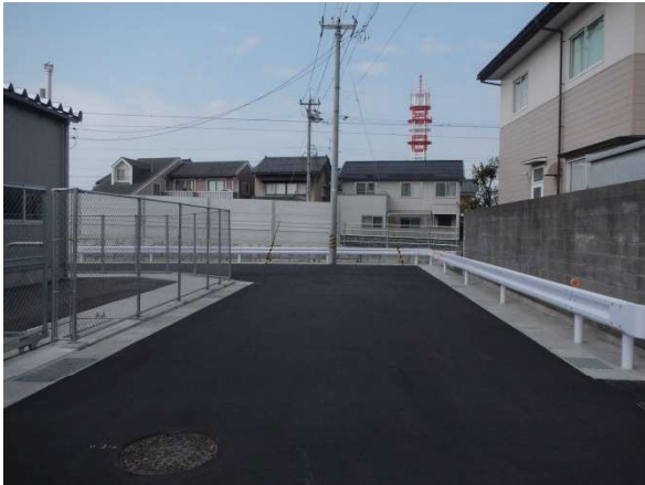
高架側道 2 号線 (終点側)
