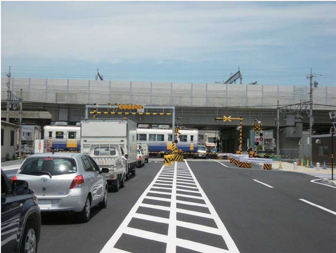
平成 21 年 6 月～平成 27 年 9 月（踏切撤去前）
