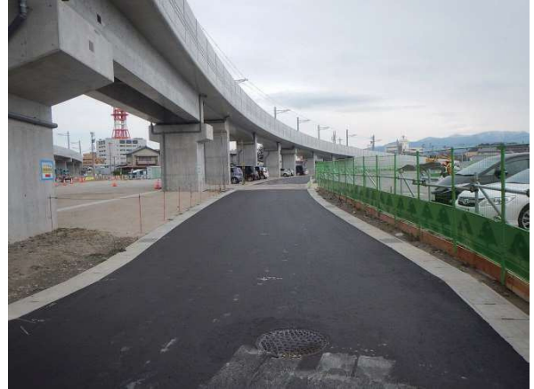
高架側道 2 号線 (起点側)
