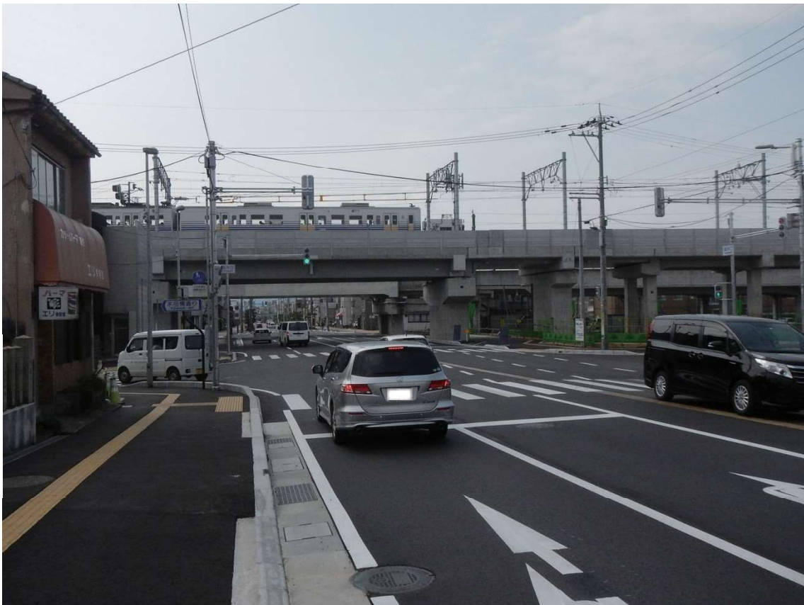
平成30年6月～ (踏切撤去後)
