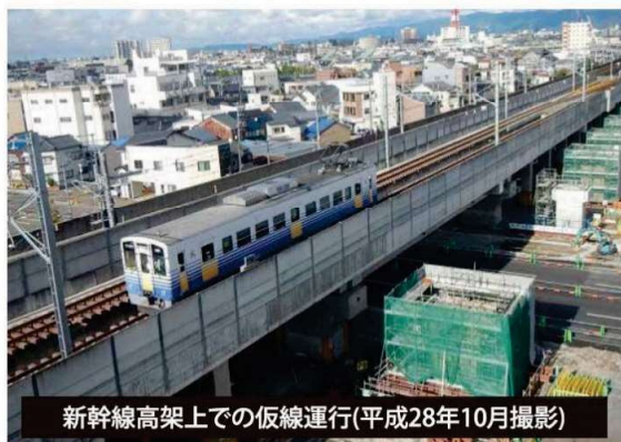
写真1 北陸新幹線高架を利用した仮線運行
