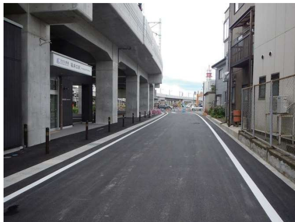
高架側道3号線（終点側）
