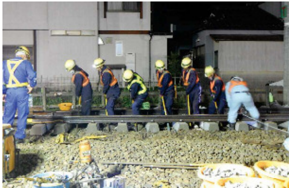
写真 9 線路切替作業
