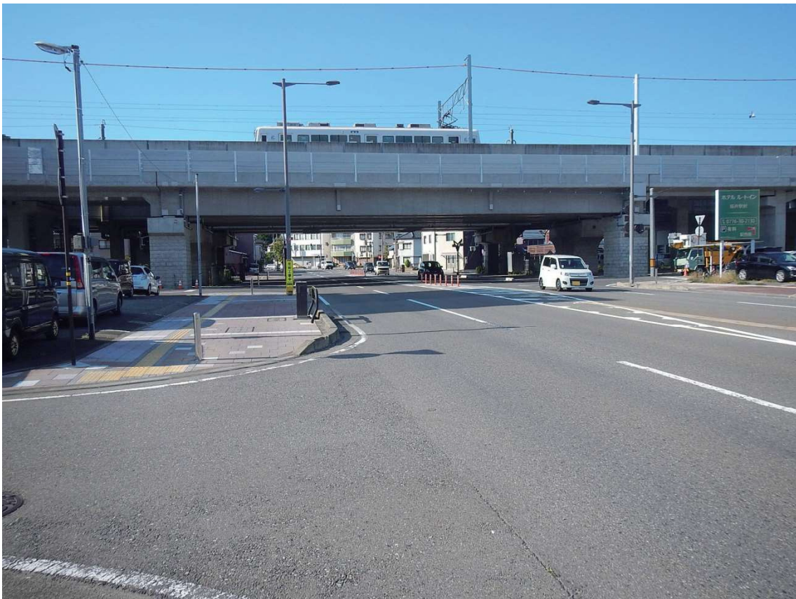
平成 27 年 9 月～（踏切撤去後）
