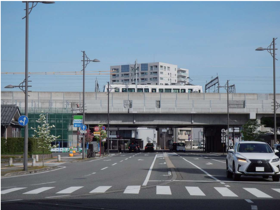
平成 27 年 9 月～（踏切撤去後）
