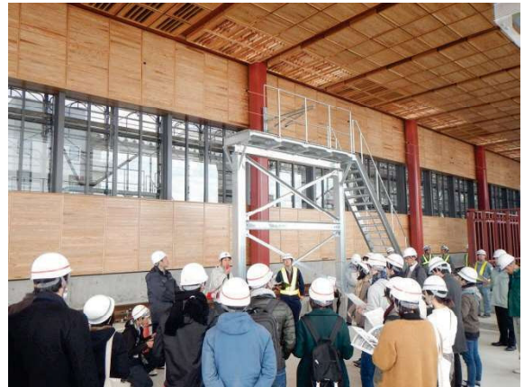
写真6 福井大学生現場見学会の様子
