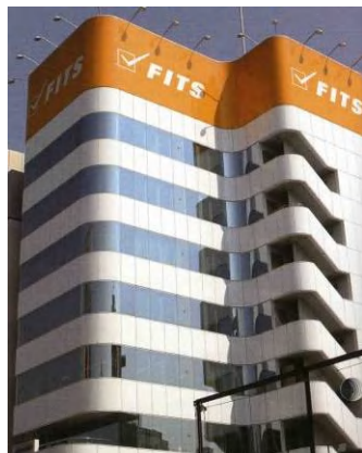
建物コーナーのアーチをそのまま延長した屋上広告。 (4)
