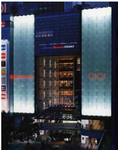
駅前広場へ清涼感を与えるガラススクリーンに、壁面広告が压迫感のない規模でバランスよく配置されています。(神奈川県川崎市、川崎駅東口広場) (1)
