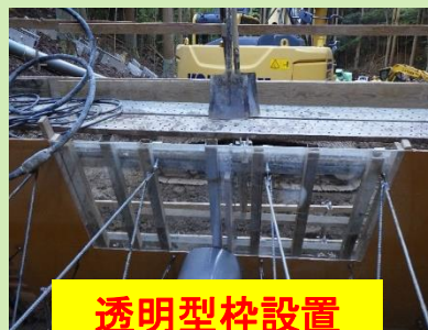
ピカコンによる気泡除去
