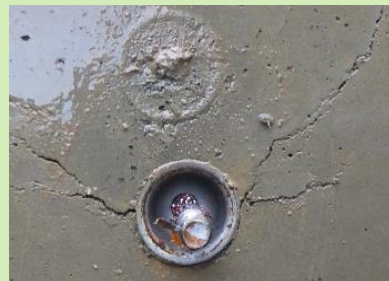
透明型枠設置
