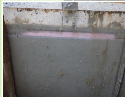
ピカコンによる気泡除去
