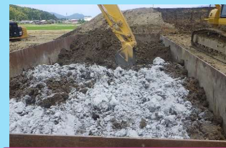
攪拌混合機を用いた盛土材の改良
