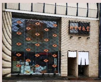
小売店舗の外観整備
