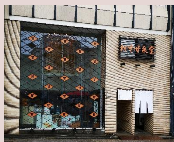
小売店舗の外観整備
