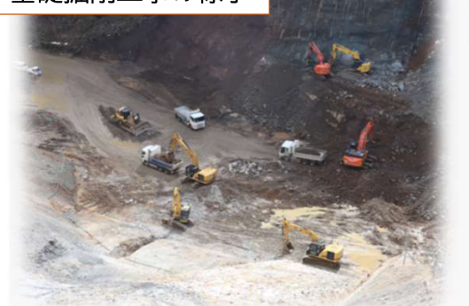
基礎掘削工事の様子
