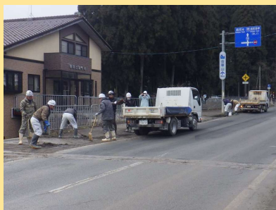
土砂運搬経路の清掃作業状況
