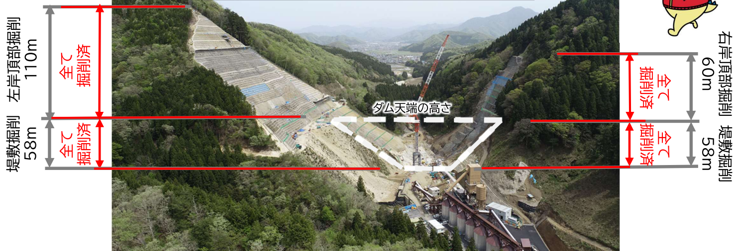
基礎掘削工事の完了 (下流から上流方向を望む)
