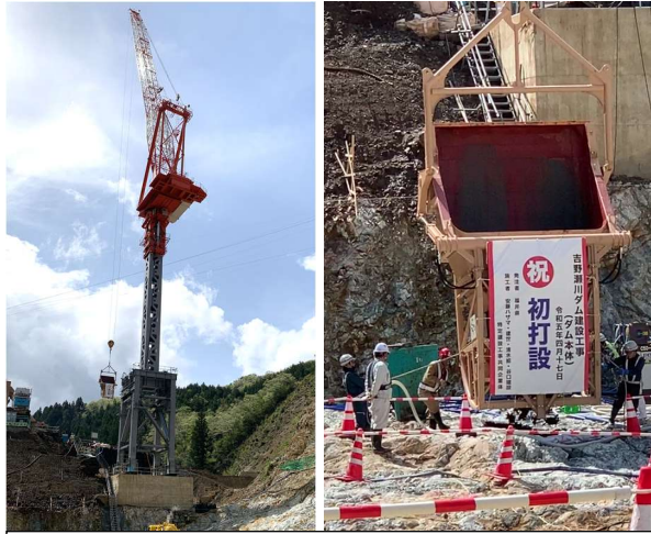
コンクリート打設設備(タワークレーン)
