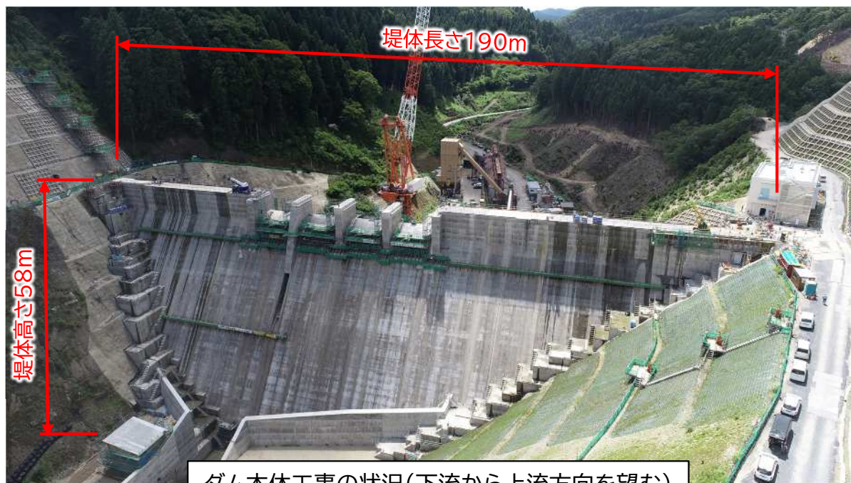
ダム本体工事の状況(下流から上流方向を望む)
