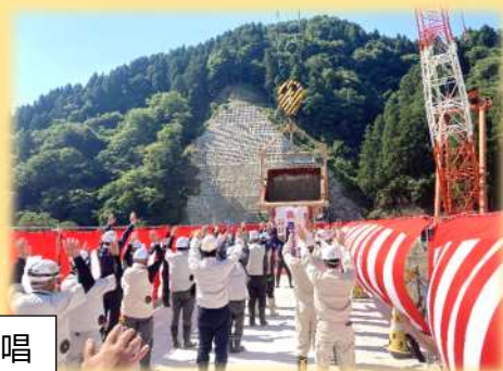
コンクリート 最終打設の様子
