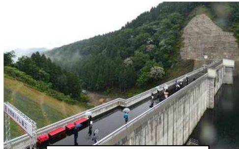
竣工した吉野瀬川ダム
