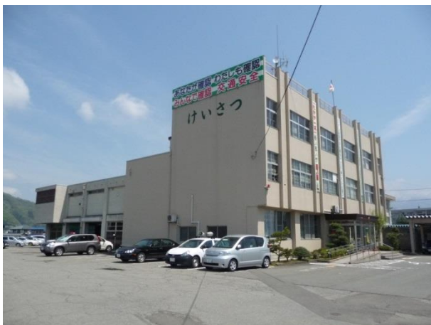
大野警察署 (昭和46年建築)
