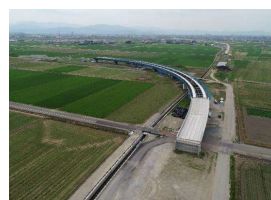
【福井港丸岡インター連絡道路(整備中)】
