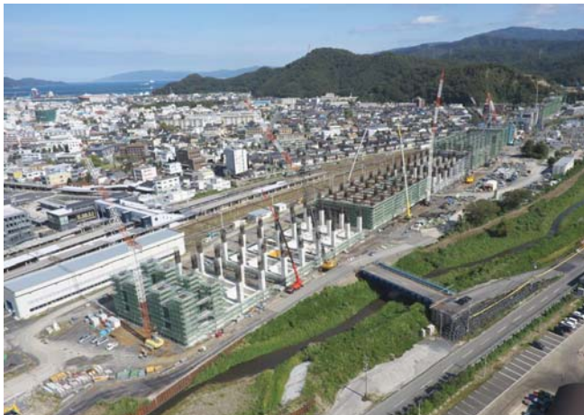
【敦賀駅高架橋】
