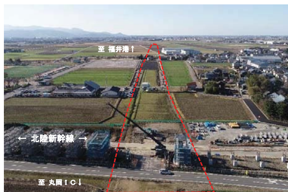
福井港丸岡インター連絡道路 【北陸新幹線交差部付近（坂井市丸岡町長崎）】
