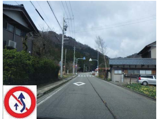
【摩耗したセンターラインの補修】
