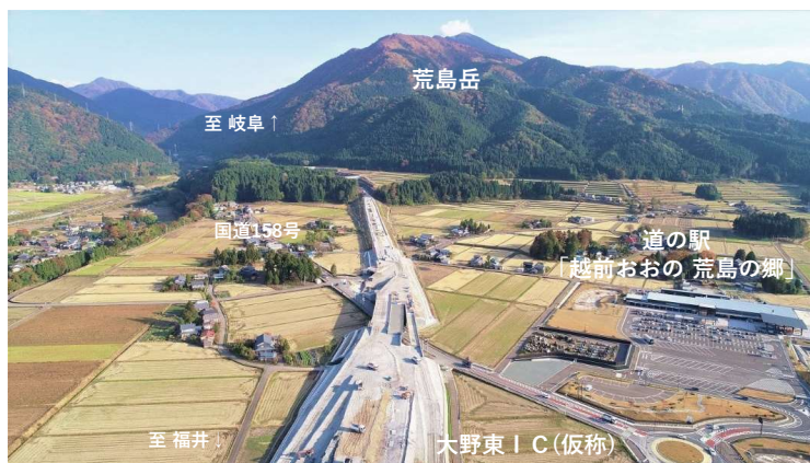
中部縦貫自動車道（大野油坂道路） 【大野東IC(仮称)付近（大野市蔵生）】
