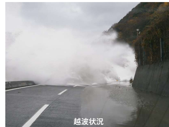
【越波対策（消波ブロック設置） ：国道305号 南越前町大谷】
