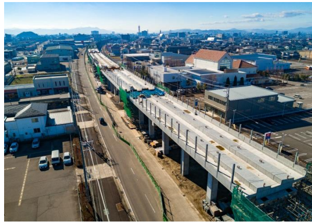
【福井高柳高架橋工事】
