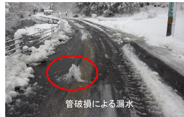
【散水管補修 (福井四ヶ浦線)】
