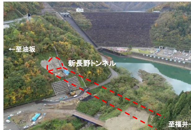
大野油坂道路 【新長野トンネル（仮称）付近（大野市長野）】
