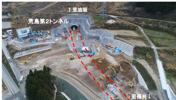
大野油坂道路 【荒島第2トンネル（仮称）付近（大野市西勝原）】
