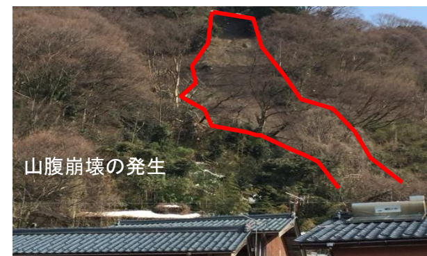
【崩壊山地の復旧 (南越前町大谷)】
