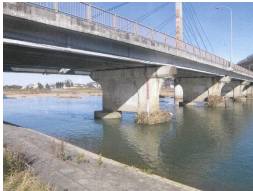
【橋梁下部工(耐震補強前)】
