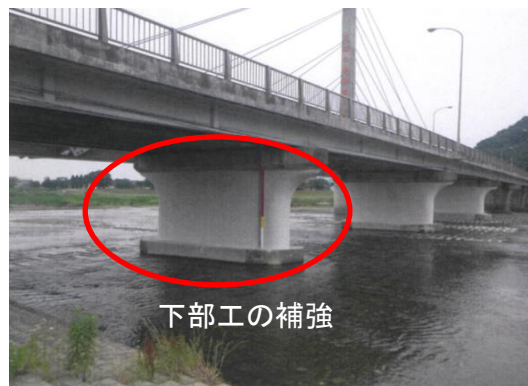
【橋梁下部工(耐震補強後)】
