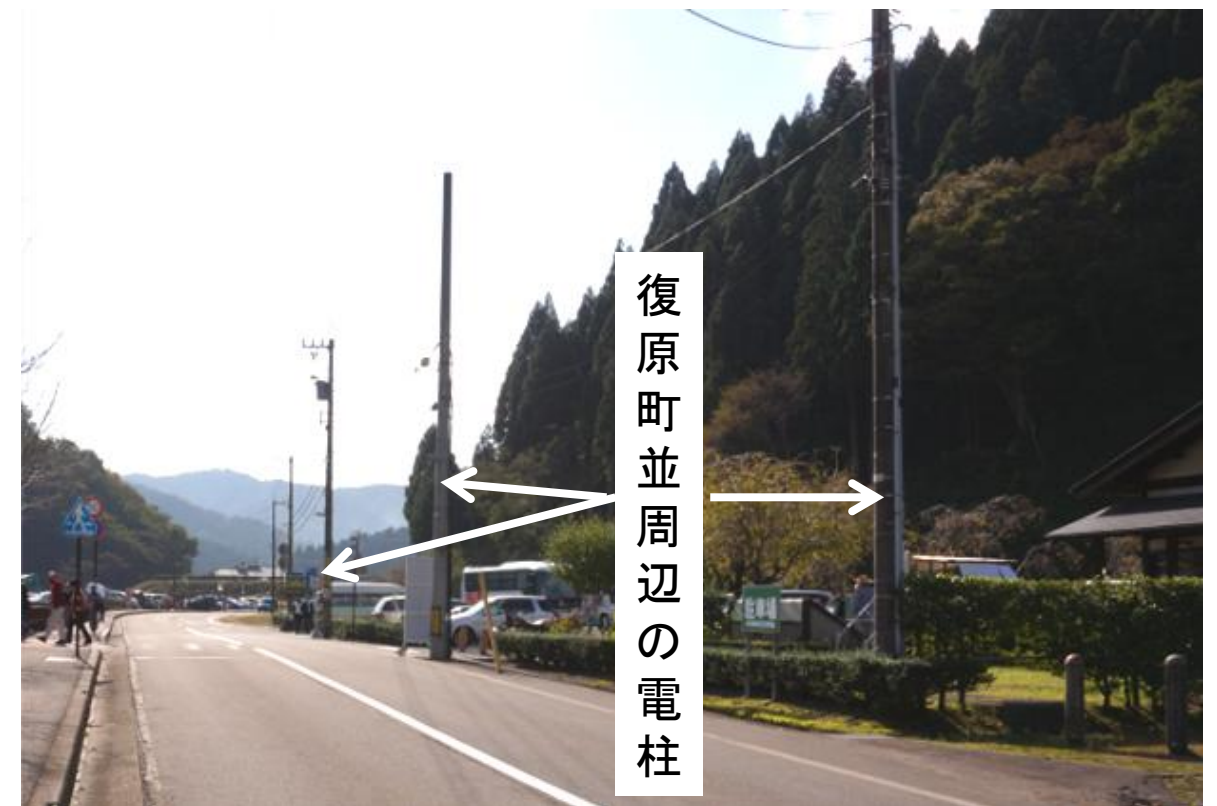
【 無電柱化する上城戸跡までの区間 】
