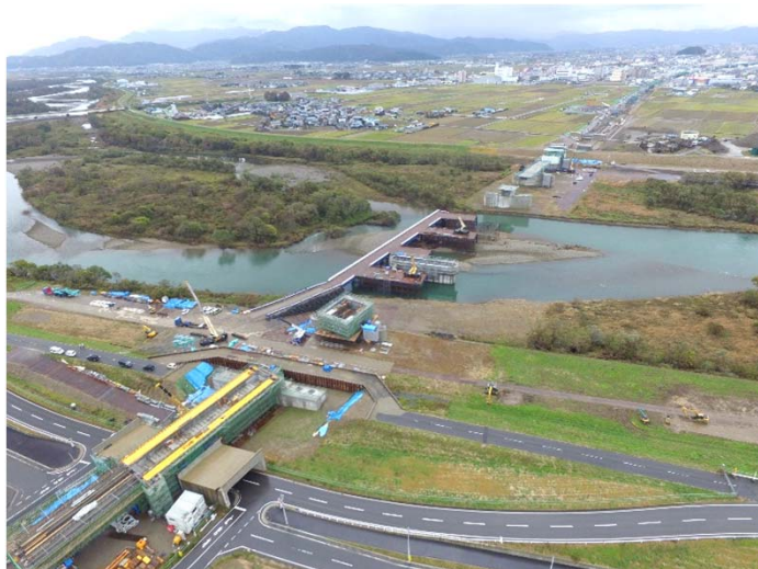
【九頭竜川橋りょう工事】
