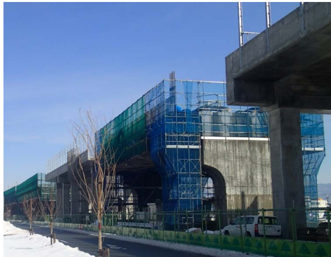
【福井高柳高架橋工事】
