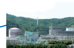
日本原子力発電(株) 敦賀発電所
